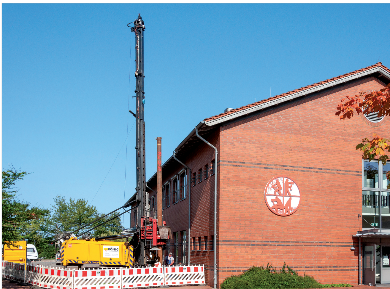
Pfahlgründung für den Anbau des Speisesaals
