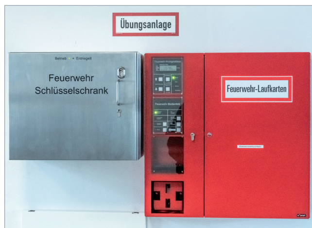
Die neue Übungsbrandmeldeanlage
